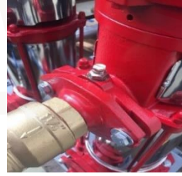
الشكل 8.1 سدادة أخذ الهواء من المضخة
