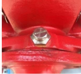
الشكل 8.1 سدادة أخذ الهواء من المضخة
