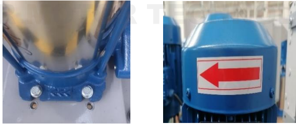
Şekil 2.3 Pompa dönüş yönleri
